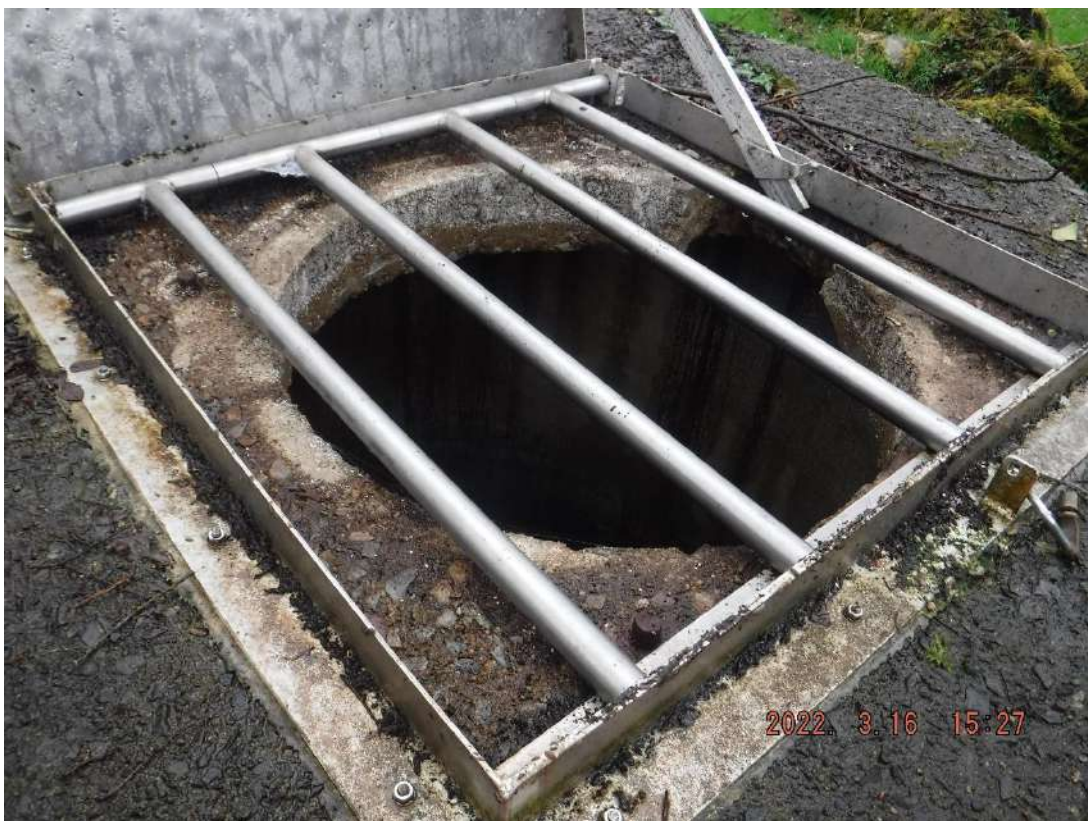
Photo 2 : Puits P1 (accès)
