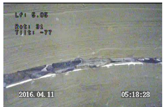
Prof 5.05 m : vue latérale / jonctions décalées de deux buses / parois propres
