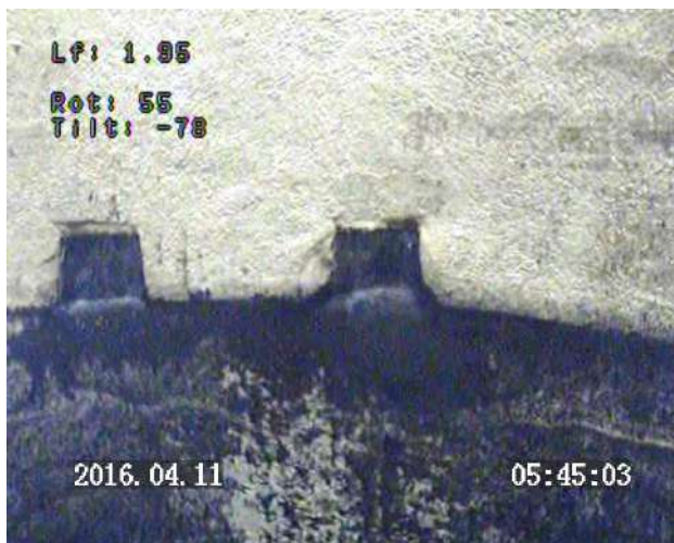
Prof 1.95 m : vision axiale / buse pleine en béton avec barbacanes / parois avec dépôt
