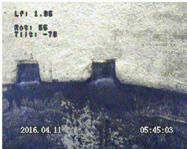
Prof 1.95 m : vision axiale / buse pleine en béton avec barbacanes / parois avec dépôt
