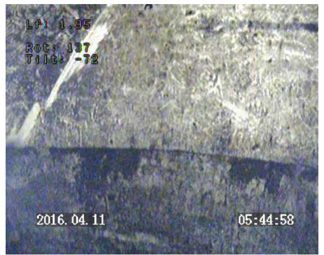
Prof 1.95 m : vue latérale / jonction entre deux buses en béton pleine / parois avec dépôt
