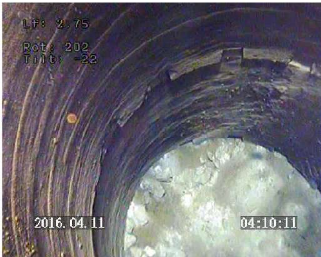
Prof 2.75 m : vision axiale / buses pleines en béton et buses avec des barbacanes / parois propres
