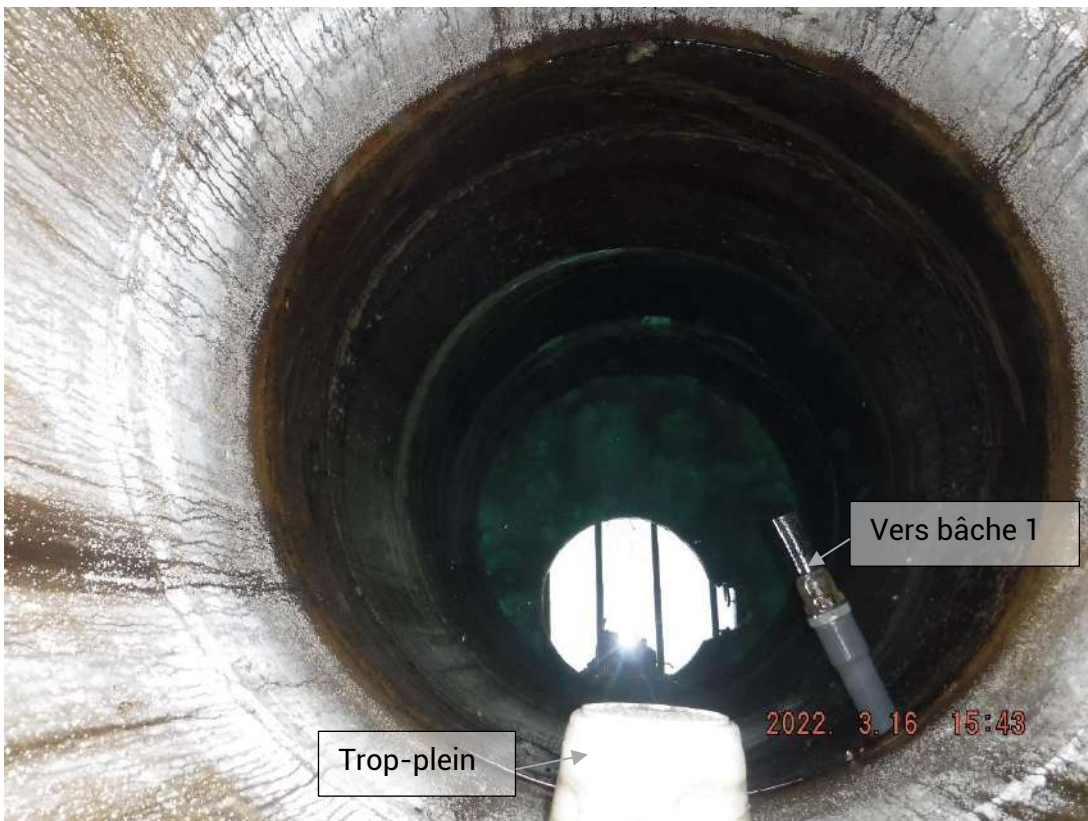
Photo 6 : Puits P2 (intérieur)
