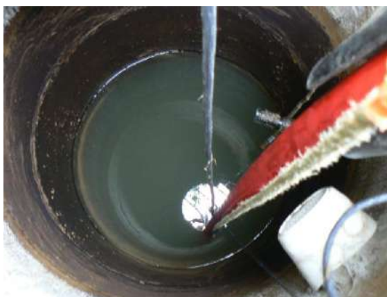
Figure 20 - Eau turbide dans le puits P2 pendant le pompage
