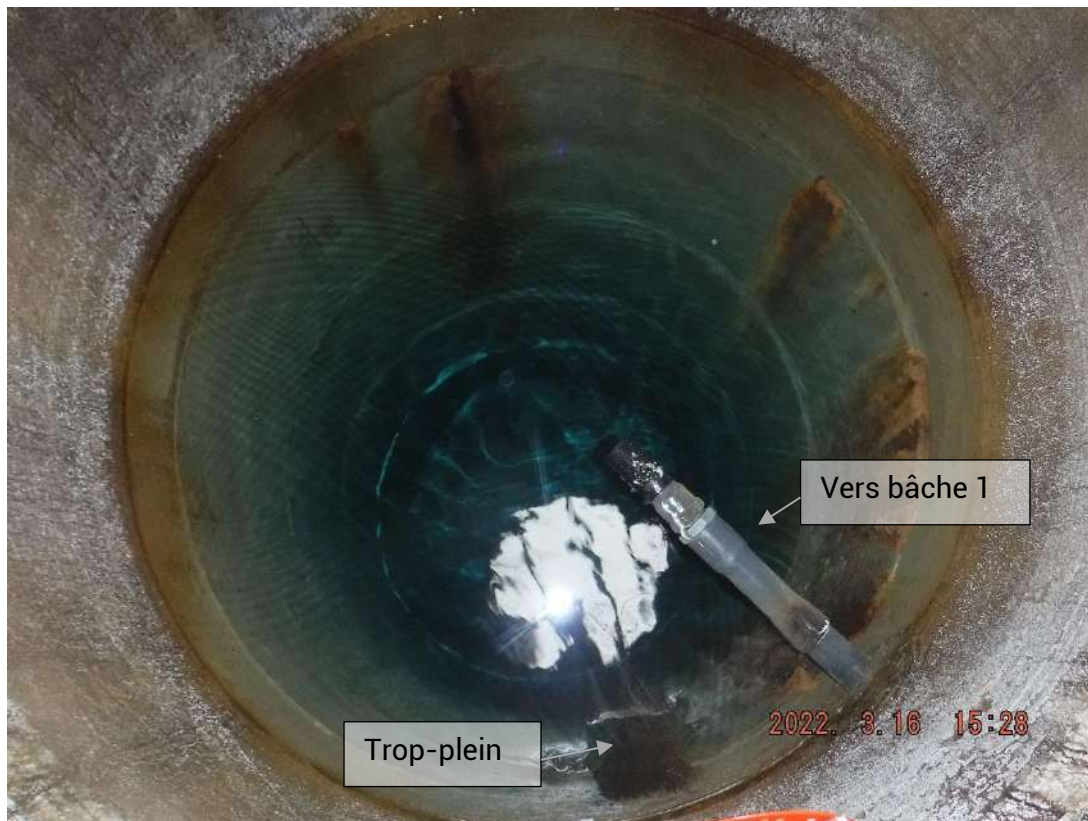
Photo 3 : Puits P1 (intérieur)
