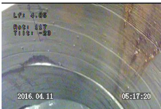
Prof 4.05 m : vision axiale / buse en béton / parois propres avec quelques dépôts d'hydroxyde de fer
