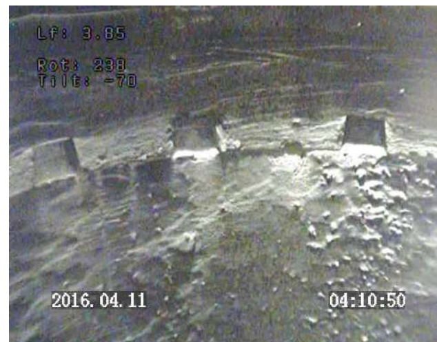
Prof 3.85 m : vue latérale / barbacanes ouvertes / léger dépôt sur les parois
