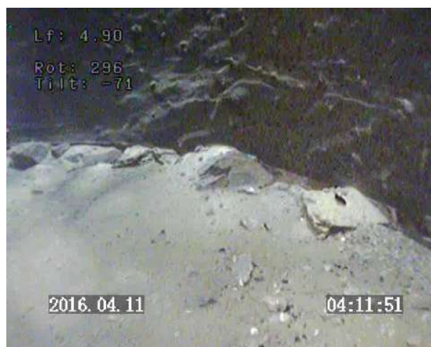
Prof 4.90 m : vue latérale au fond du puits / buse béton pleine
