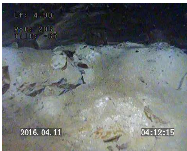
Prof 4.90 m : vue latérale / barbacanes légèrement obstruées par des dépôts
