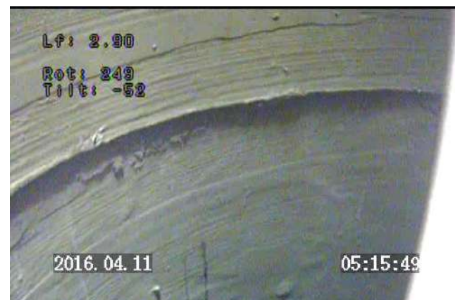
Prof 2.90 m : vue latérale / jonction entre deux buses pleines en béton / parois propres
