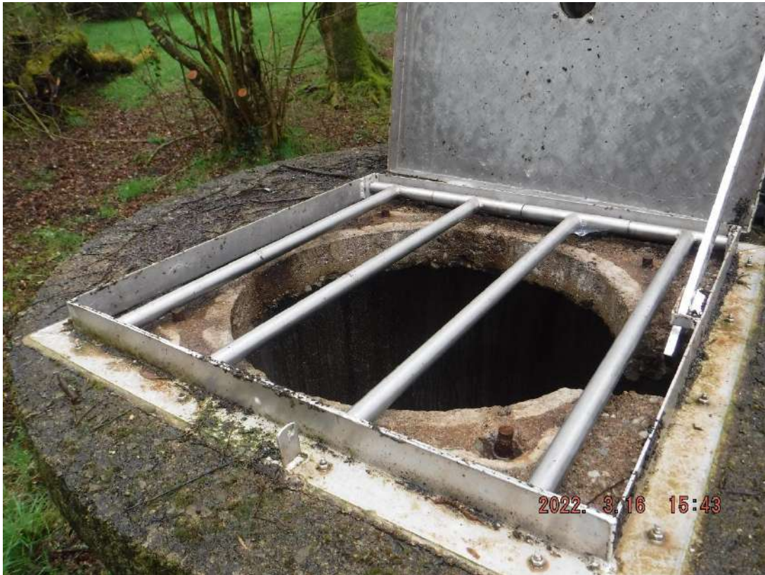
Photo 5 : Puits P2 (accès)
