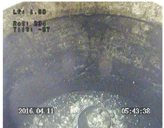
Prof 1.60 m : vision axiale / vue sur le fond / buse pleine en béton
