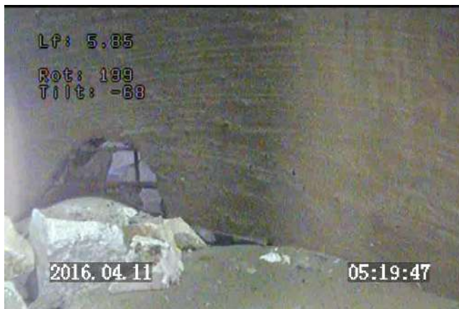
Prof 5.85 m : vue latérale au fond du puits / barbacane ouverte / parois propre
