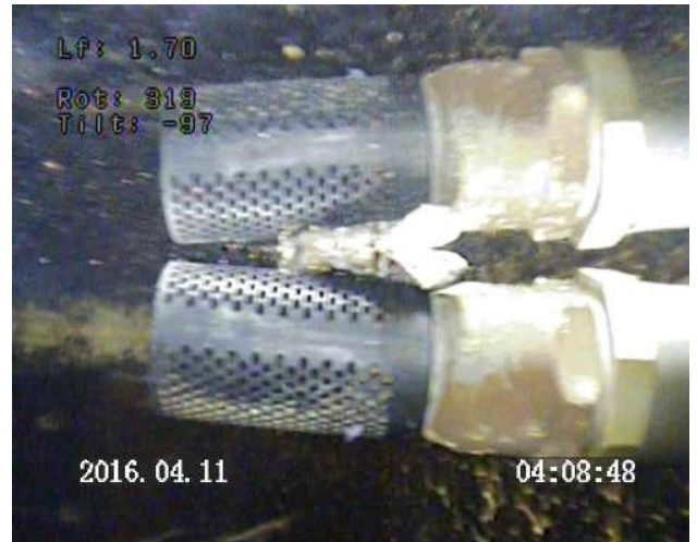
Prof 1.70 m : vue latérale / vue sur la prise d'eau / buse pleine en béton
