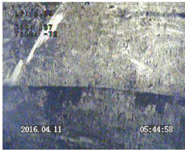
Prof 1.95 m : vue latérale / jonction entre deux buses en béton pleine / parois avec dépôt
