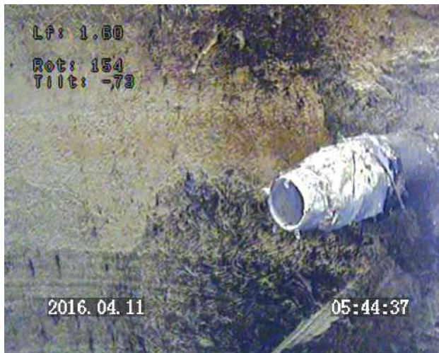
Prof 1.60 m : vision latérale / vue sur la prise d'eau / buse pleine en béton avec quelques dépôts sur les parois
