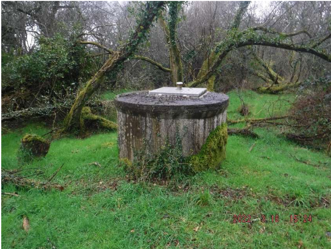
Photo 1 : Puits P1 (extérieur)
