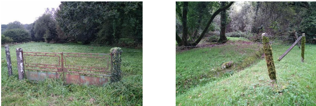
Figure 7 : Portail et puits P2 au fond (photo de droite) / Clôture et fossé (photo de gauche)
